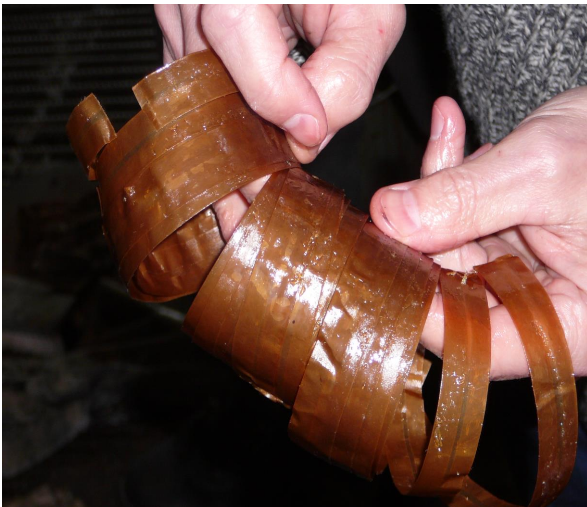
Рис. 2. Воскообразные отложения на слоях бумажной изоляции трансформатора тока типа ТФЗМ-110.
